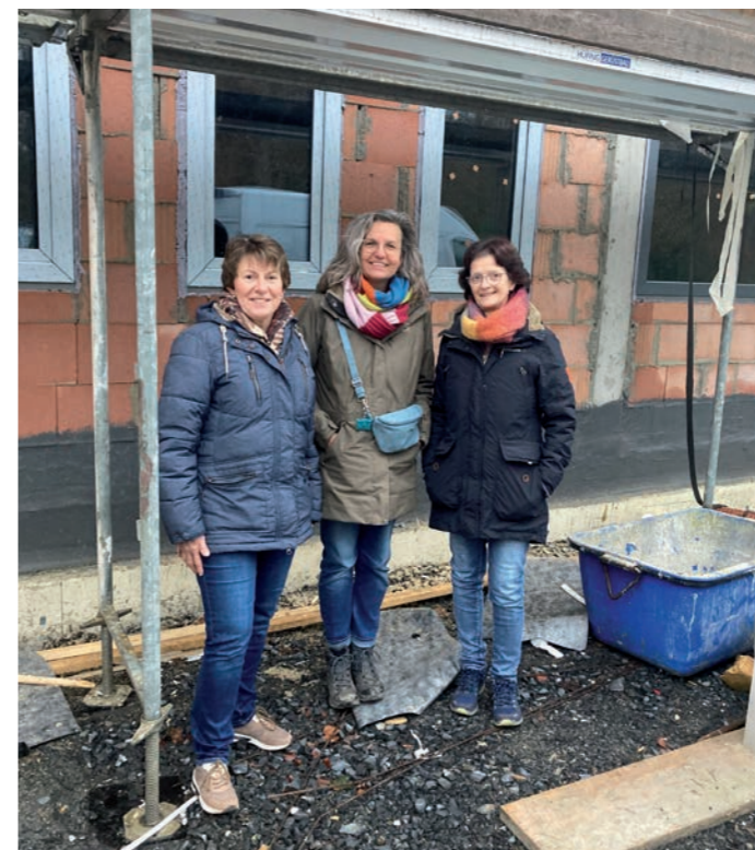
Der Neubau schreitet voran (v.l.): Hedwig Sicking, Sandra Kassenböhmer und Birgit Roesmann vom geschäftsführenden Vorstand besichtigen die Baustelle./Foto: privat
